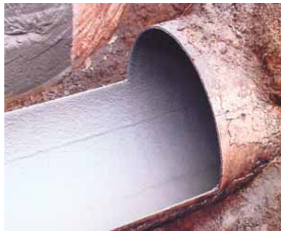
Рисунок 3. Внутренняя поверхность трубопровода после обработки
