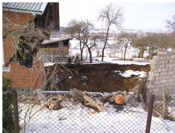
Рис. 1. Провал жилого дома в полость
