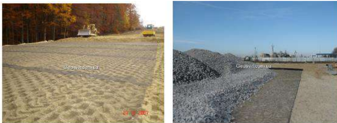
Рис. 12. Армування основи дорожнього полотна георешітками
