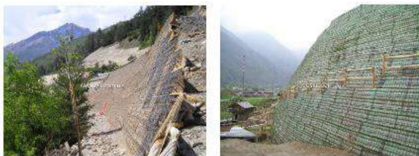
Рис. 10. Армування відкосів. Армоґрунтові підпірні стіни
