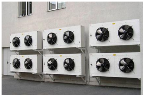
Рис. 2. Утилізація тепла на вулицю за допомогою повітряних конденсаторів
