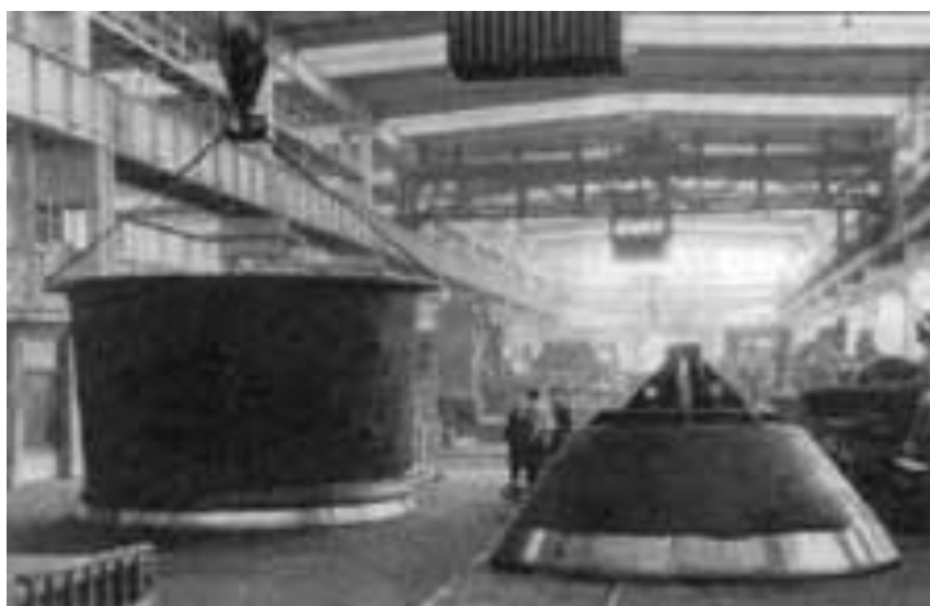
Рис. 2. Общий вид конуса и чаши засыпного аппарата.
