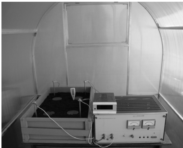
Рисунок 3 – Внешний вид электротехнической установки
