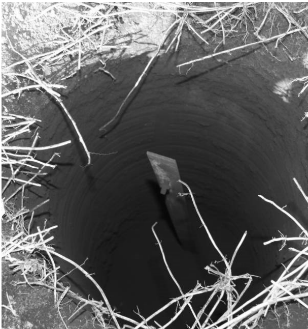
Рисунок 1 – Монтаж вертикального електрода підвищеної провідності розтіканню: засипка свердловини технічним вуглецем
