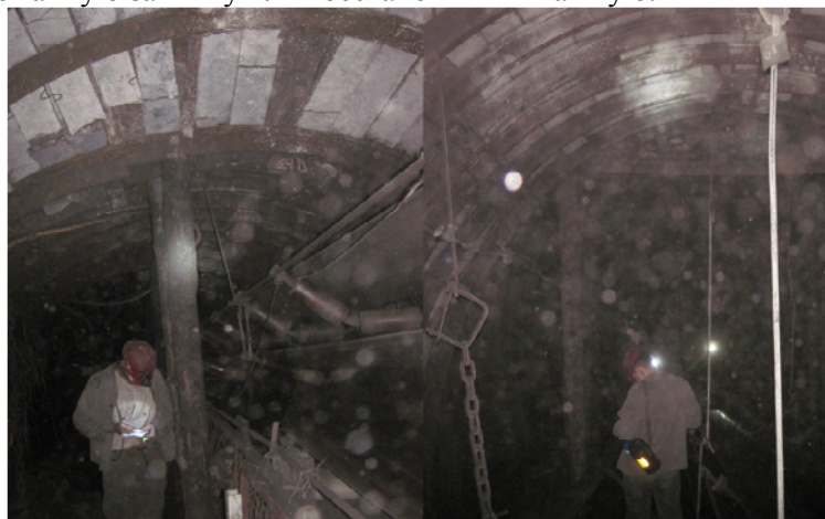
Рис. 3. Примеры усиления крепи южного уклона II ступени пл. I 1
