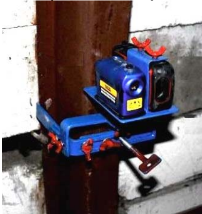
Рис. 3. Установка измерительного устройства на стойке металлической крепи
