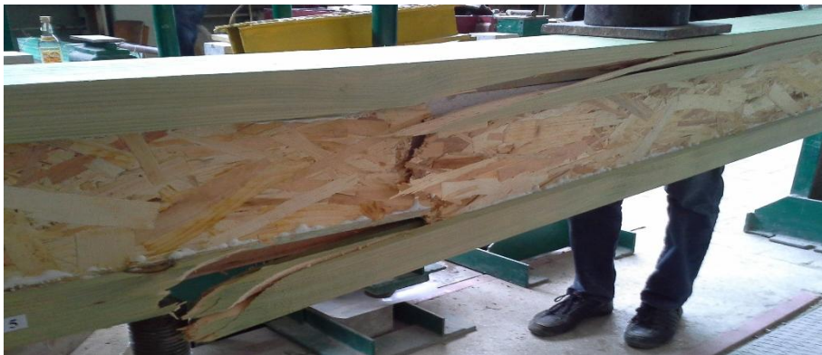
Рис. 7. Місце руйнування стінки та полицок балки Б-2.
