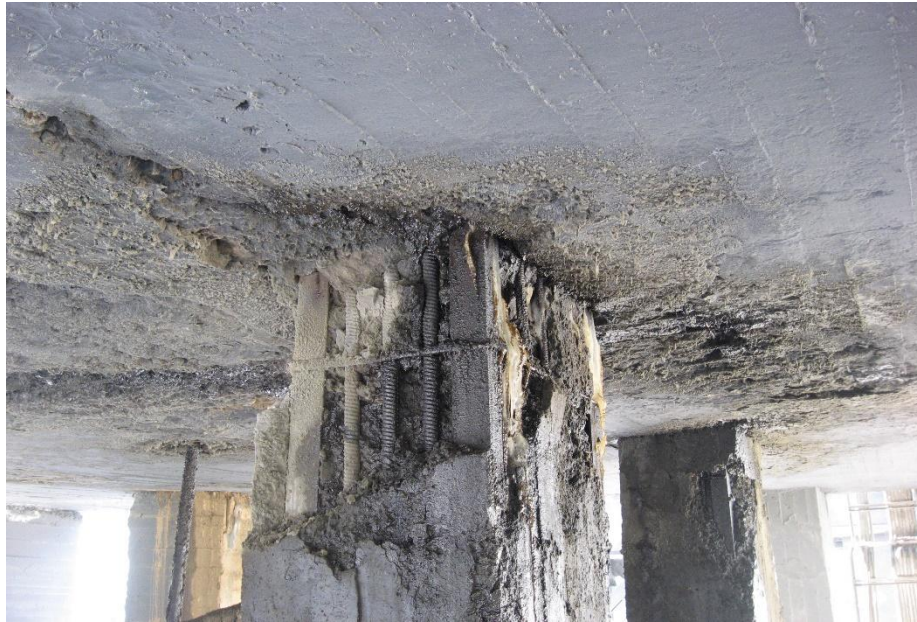
Рис. 5. Обпирання плити на колону опори П5/О4.
