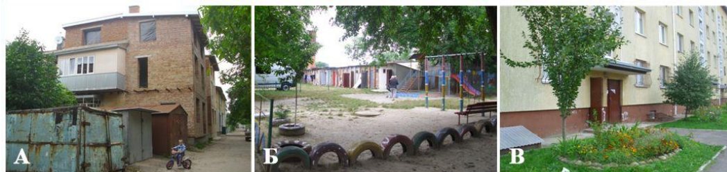
Рис. 2. а) стихійна реконструкція двоповерхового гуртожитку; б) благоустрій житлового кварталу; в) прибудинковий благоустрій сучасного багатоквартирного будинку.
