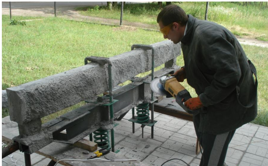
Рис. 3. Підготовка підсиленої балки серії 1 після дозрівання бетону.
