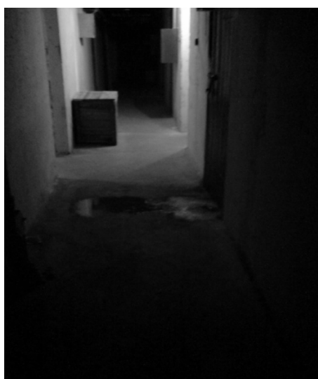
Rys. 11. Zdjęcie wykonane kamerą termowizyjną i aparatem fotograficznym. Widoczne zawilgocenia w piwnicy budynku wielkopły- towego
