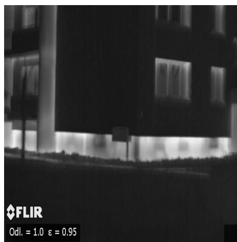
Rys. 9. Zdjęcie wykonane kamerą termowizyjną i aparatem fotograficznym. Widoczne zamurowane okienka w ścianie piwnic oraz różnica w rozkładzie temperatur dla ścian piwnic i kondygnacji powtarzalnych
