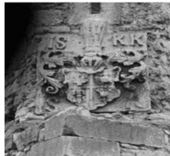
Іл. 27. Кам'яна плита на вежі Золочівського замку
