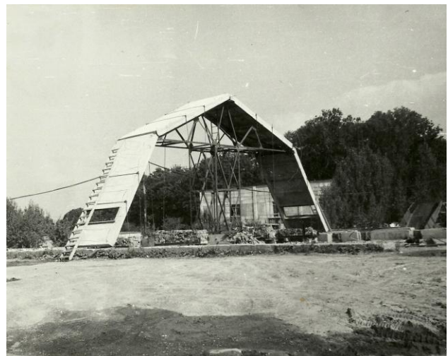
Рис. 4. Загальний вигляд фрагменту поперечника безкаркасної будівлі
