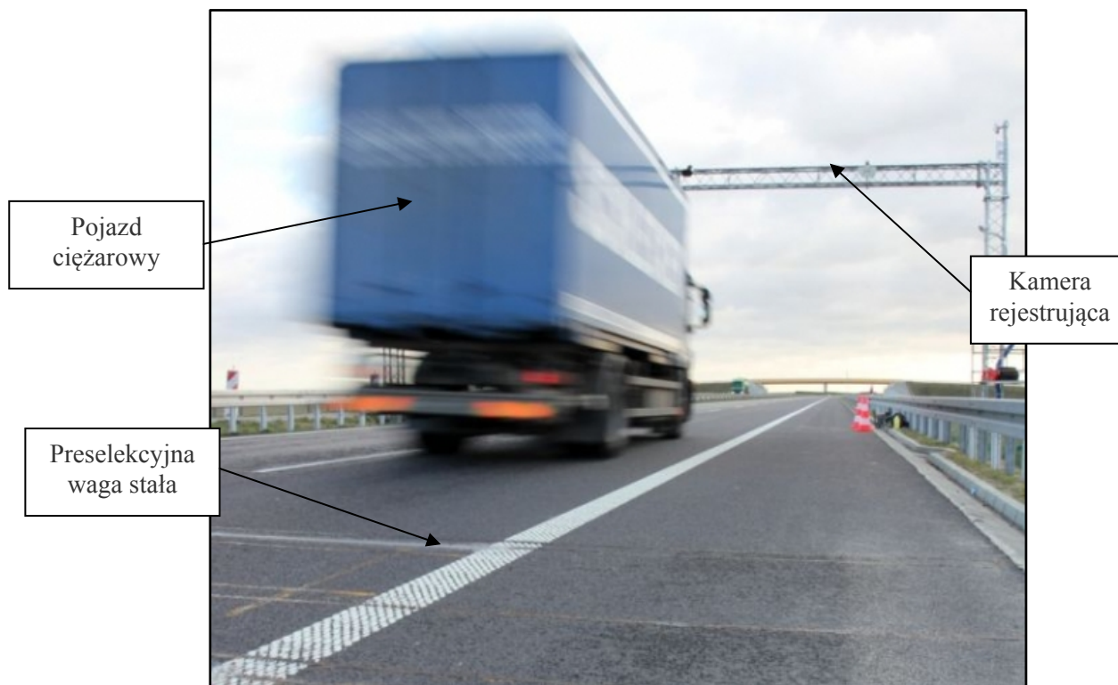
Rys.4. Przykładowy obraz rozmieszczenia elementów automatycznego ważenia pojazdów ciężarowych [5]
