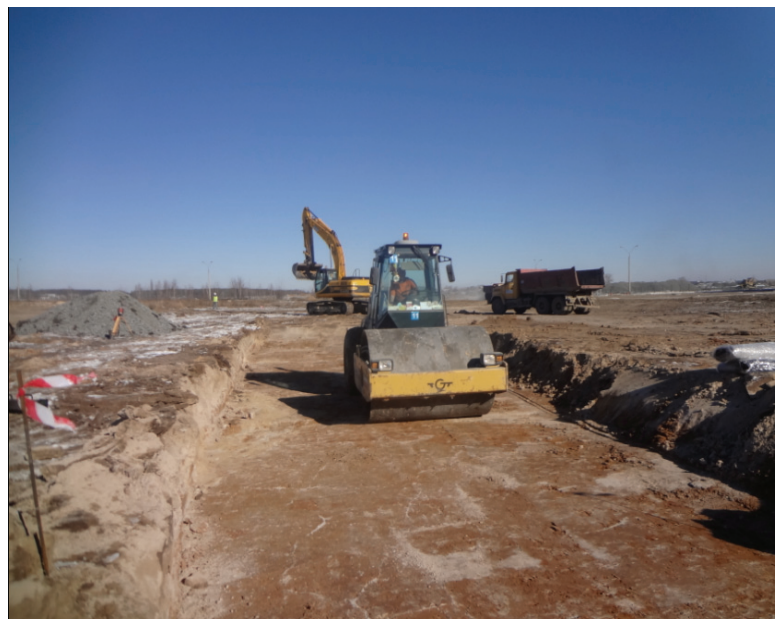
Рисунок 1 – Загальний вигляд будівельної ділянки
