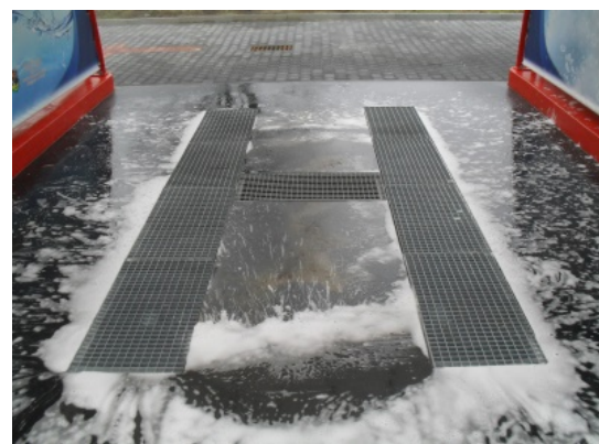
Rys.15. Płyta stanowiska z kratkami ściekowymi [11]
