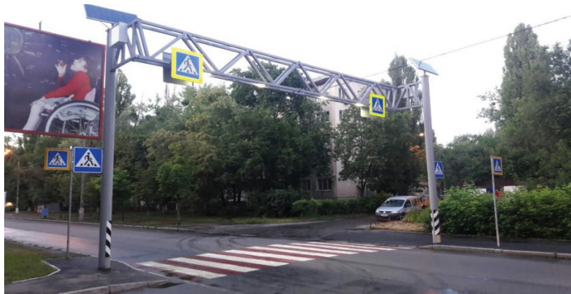
Рисунок 10 – Використання порталної конструкції на вул. Академіка Туполева (м. Київ) Figure 10 – Use of portal construction on the street Academician Tupolev (Kyiv)
