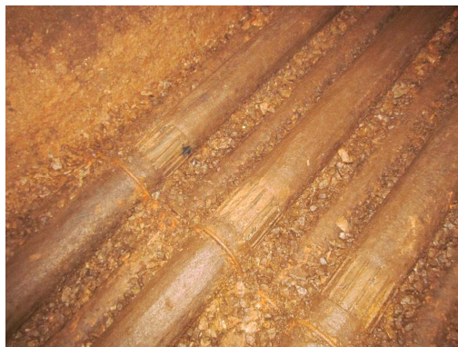
Рис. 4. Фрагмент водозабірної та аераційної системи фільтра
