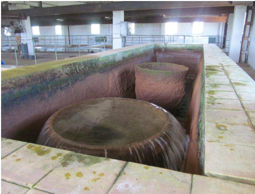
Рис. 2. Блок аерації із чашоподібною конструкцією
