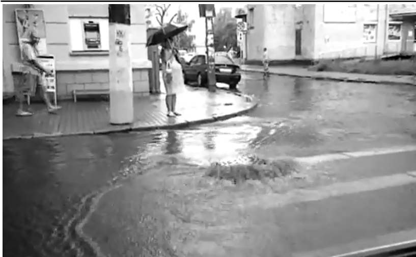
Рис. 3. Затоплення міської вулиці через люк колодязя дощової мережі (м. Житомир, 12.09.2013 р.)
