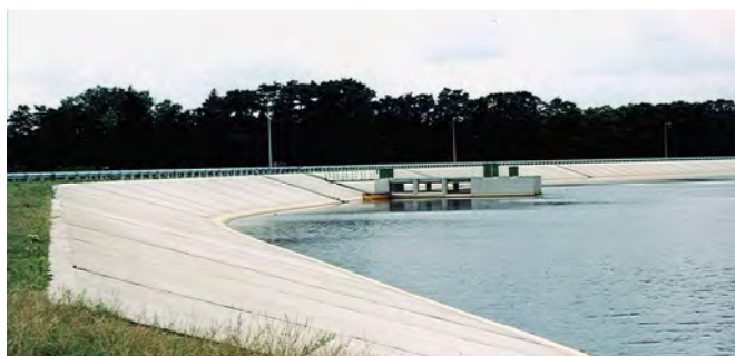
Fot. 9. Zapora ziemna – zbiornik Murowaniec na rzece Śwędźni
