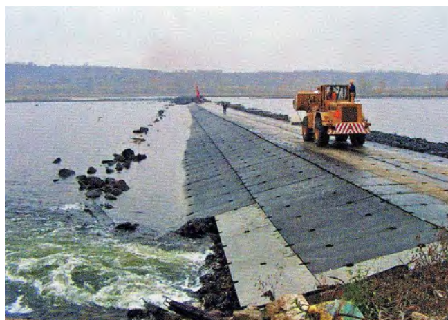
Fot. 1. Próg podpierający stopień wodny we Włocławku
