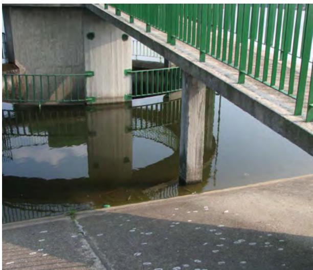
Fot. 5. Wieża upustowa zbiornika Pokrzywnica
