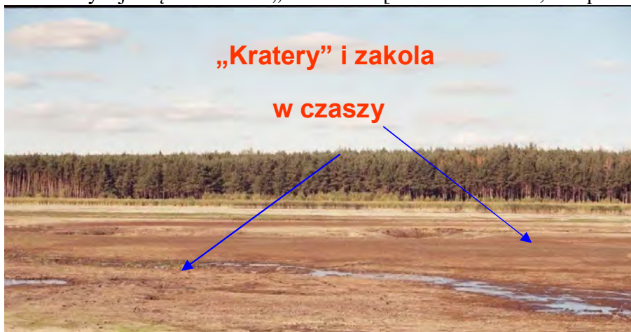
Fot. 2. Czasza zbiornika Murowaniec
