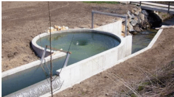
Рис. 4. Робоча ємність гравітаційно-вирової турбіни з підвідним каналом
