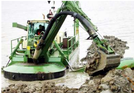
Рис. 11. Днопоглиблювальні роботи з використанням «зворотної лопати»
