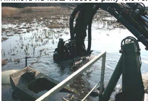
Рис. 8. Роботи з днопоглиблення з допомогою ківша-насоса
