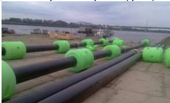
Рис. 4. Пульпопровід з навішеними поплавками
