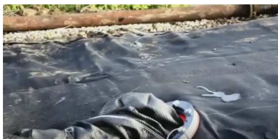
Рис. 9. Під'єднання гнучкого шлангу пульпопроводу до горловини геотуби
