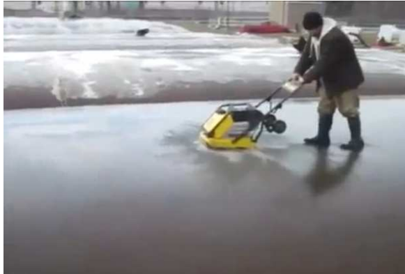
Рис. 12. Процес прискорення зневоднення з допомогою вібратора
