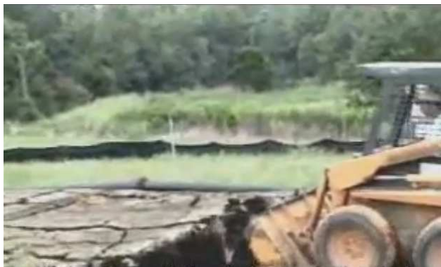
Рис. 14. Завантаження зневодненого осаду з геотуби в транспорт
