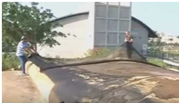
Рис. 13. Розкриття геотуби
