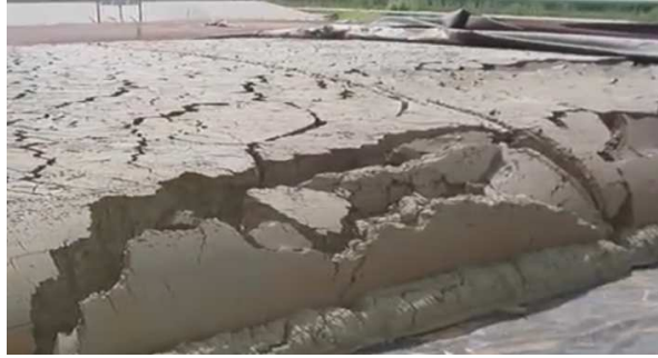
Рис. 5. Зневоднений осад після відкриття геотуби
