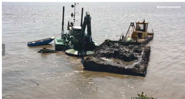
Рис. 18. Навантаження розробленого ґрунту на баржу
