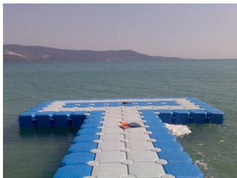
Рис. 22. Технологічний пірс з склопластикових елементів
