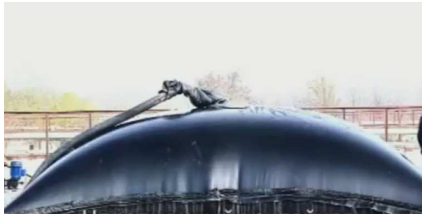
Рис. 10. Процес заповнення геотуби пульпою
