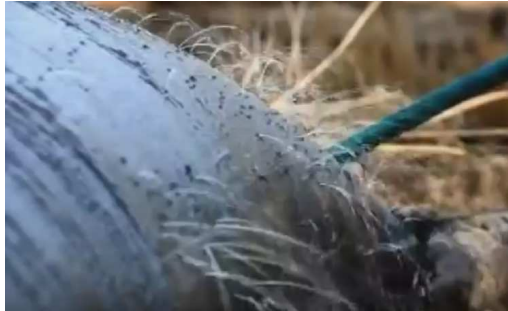
Рис. 3. Просочування води через стінки геотуби
