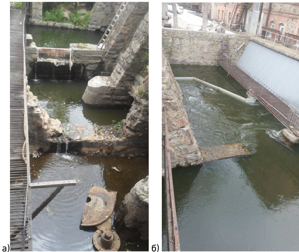
Рис. 5. Аванкамера водоприймача ГЕС: а) до реконструкції; б) існуючий стан
