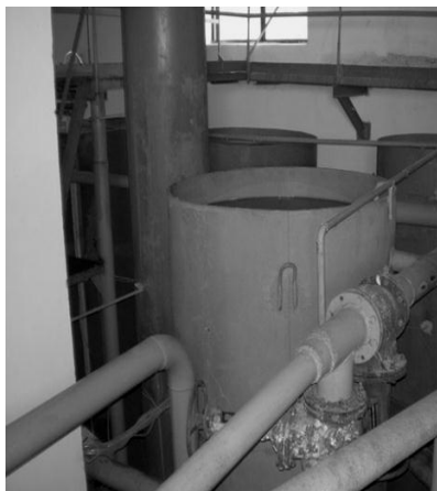
Рис. 2 Пінополістирольні фільтри з технологічними трубопроводами
