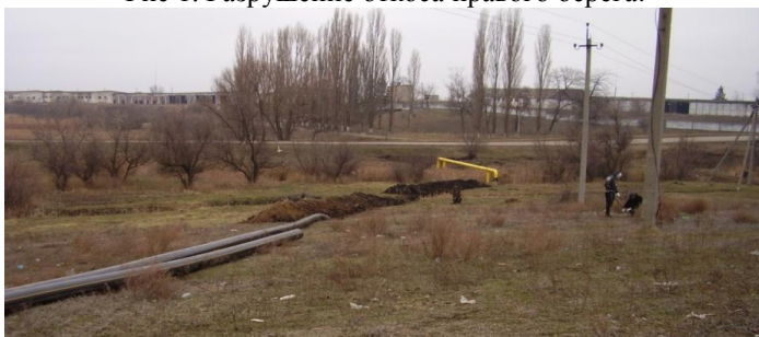
Рис 2. Труба, уложенная на низовом откосе
