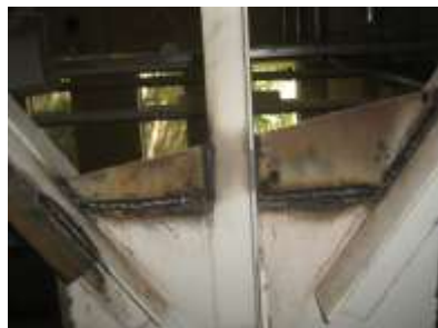
Рис. 7. Увеличение длины сварных швов
