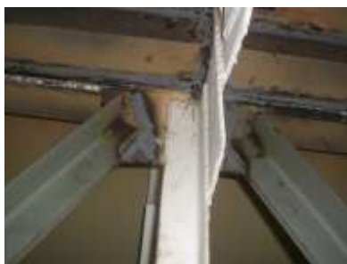
Рис. 8. Устройство подкосов шпренгелей
