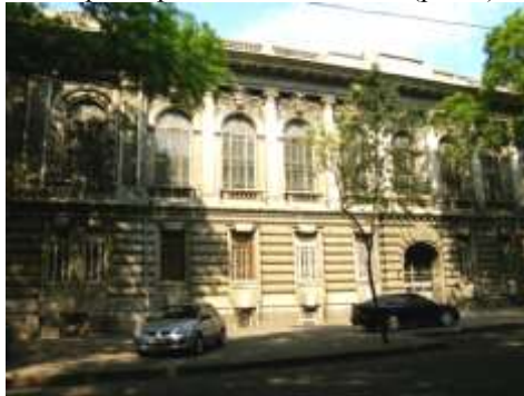
Рис. 1. Фотофиксация фасада здания по ул. Пастера 25.
