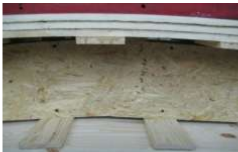
Рис. 4. Фрагмент испытанной балки с разрушенной OSB стенкой
