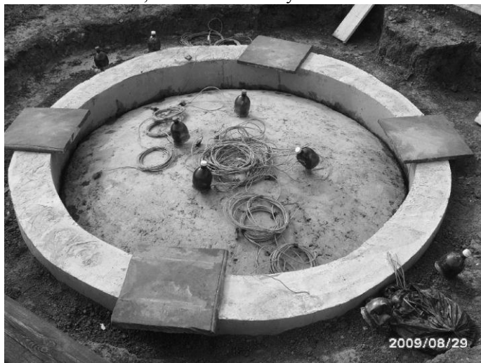
Фото 2. Осесимметричный фундамент – оболочка перед испытаниями
