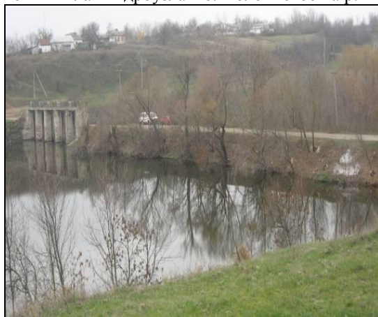
Рисунок 2 – Общий вид земляной плотины со стороны верхнего бьефа
