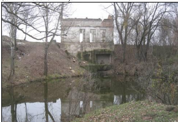
Рисунок 8 - Общий вид отводящего канала
