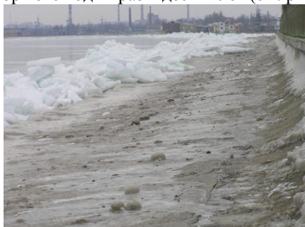
Рис.1. Воздействие ледовых образований на берегозащитное сооружение
