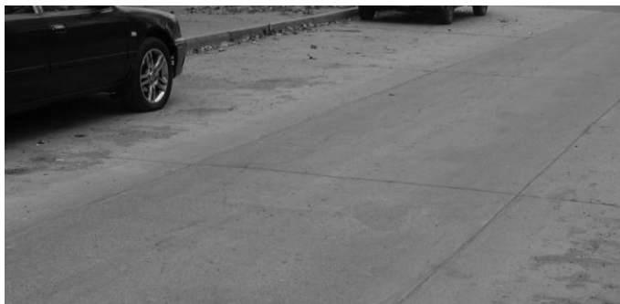
Рис.1. Состояние жестких дорожных покрытий из модифицированного фибробетона на улице Новикова после 7-ми лет эксплуатации без ремонтов
