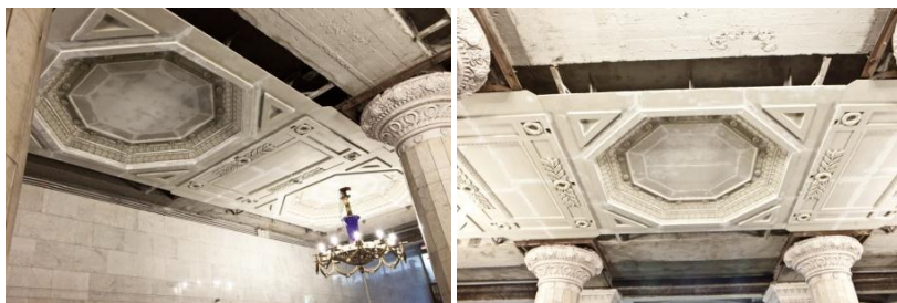
Рис. 2 – Конструкция подвесного потолка из стеклофибробетона
