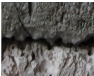
Рисунок 1 Трещинообразование: а) в контактной зоне «газобетонное основание –штукатурное покрытие»; б) в объеме штукатурного раствора с) и на его поверхности
