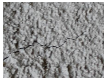
Рисунок 1 Трещинообразование: а) в контактной зоне «газобетонное основание –штукатурное покрытие»; б) в объеме штукатурного раствора с) и на его поверхности
