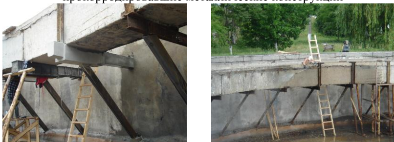
Рис.3. Процессы восстановления опорных конструкций и гидроструйная очистка бетона и арматуры
