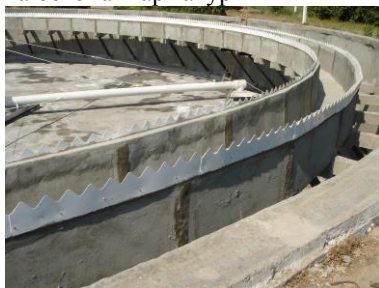
Рис.3. Процессы восстановления опорных конструкций и гидроструйная очистка бетона и арматуры
