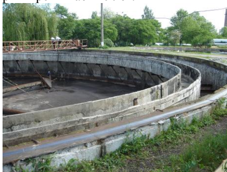
Рис. 1. Объект до ремонта
