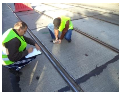
Рис.4. Определение прочности бетона ультразвуковым методом
