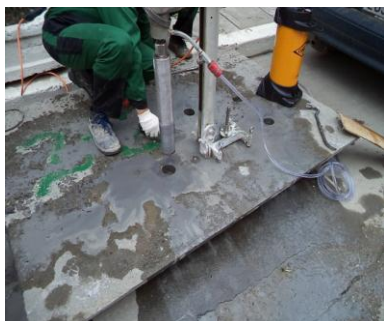
Рис.5. Выбуривание образцов из конструкций
