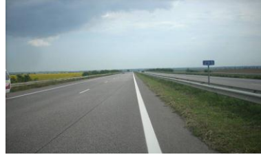
Рисунок 2– Стан ділянки, км 295, 2014 р., значні дефекти відсутні
