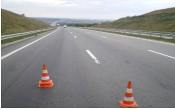
Рисунок 1 – Стан ділянки, км 300 – 2010 р. Значні дефекти відсутні, колія до 10 мм
