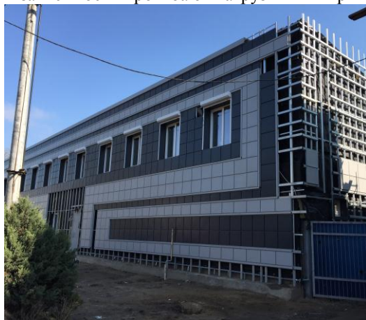
Фото 2. Вид фасада реконструируемого здания
