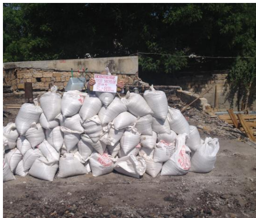
Фото 1. Нагружение плиты покрытия нагрузкой 1800 кг
