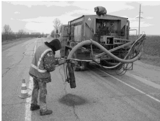
Рис. 3. Машина ямкового ремонту УЯР-01 на базі автомобіля КАМАЗ
