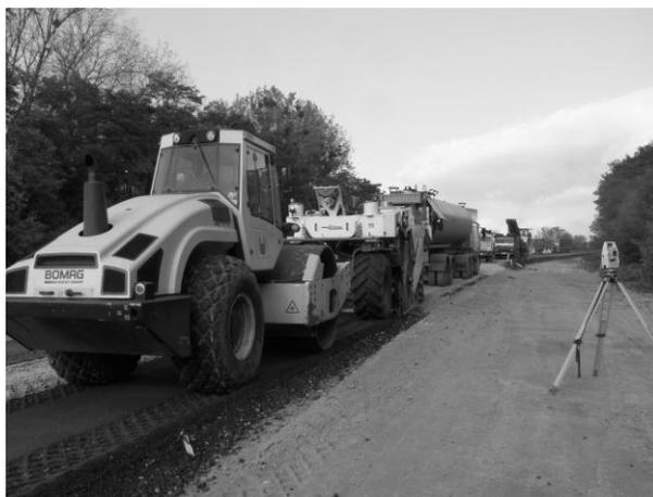
Рис. 2 Технологический процесс восстановления конструкции дорожной одежды по технологии «холодный ресайклинг» (автодорога М-06 Кив-Чоп, км 348 – км 441 (Ровенская область))
