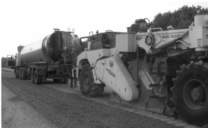
Рис. 1 Работа комплекса Wirtgen при ремонте покрытия по технологии «холодный ресайклинг» на автодороге М-06 Кив-Чоп км 348 – км 441 (Ровенская область)
