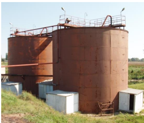
Рис. 2. Аеротенк-відстійник підвищеної гідравлічної висоти
