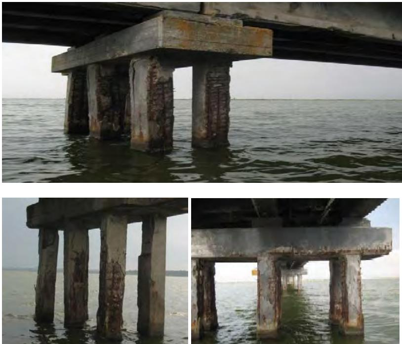
Рис. 1. Интенсивная коррозия опор пролетного строения мостового сооружения от действия агрессивной среды
