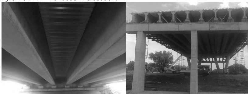
Рис. 1. Споруджувані міст (зліва) та шляхопровід (справа) із ППЧ зі СПН на автомобільній дорозі Київ-Харків
