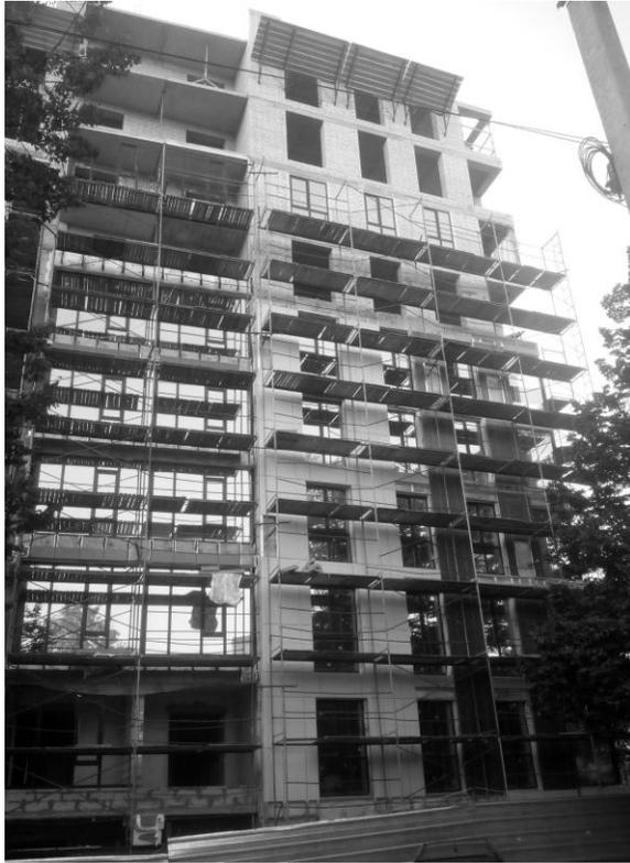
Рис. 4. Организация процесса устройства вентилируемого фасада с облицовкой керамогранитом на объекте «Жуковский» в г. Днепропетровск
