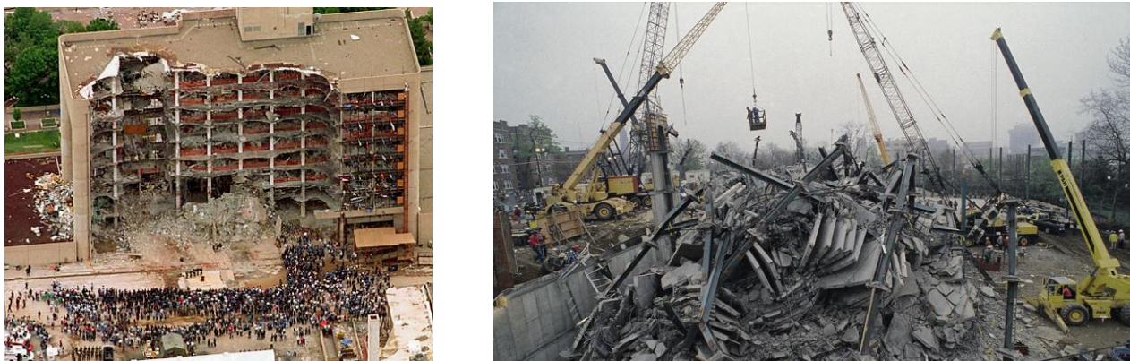
Рис. 1. Будівля «Alfred P. Murrah Federal Building» після теракту 19 квітня 1995 р. (зліва), та уламки зруйнованого будинку L'Ambiance Plaza внаслідок технологічної помилки при будівництві (справа)
