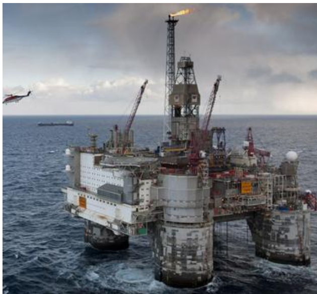
Рис.1. Плавуча нафтова платформа Heidun. Побудована з легкого бетону класу LC-60
